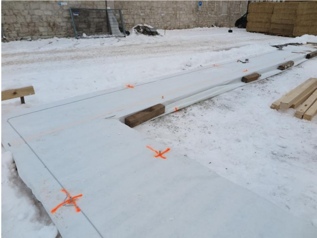
Abbildung 47 Sensorinstallation im Bereich der Gebäudeecke: TDR-2-Sensor auf Innenseite durchlaufend, Satsensor außen umlaufend um Gebäudeecke (15 cm nach innen versetzt)
