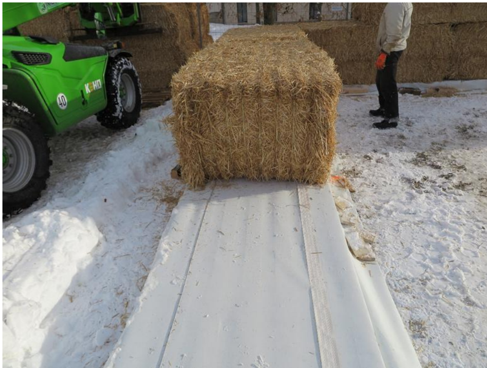
Abbildung 48 Verlegen der ersten Strohballenlage auf die installierten TDR-Sensoren
