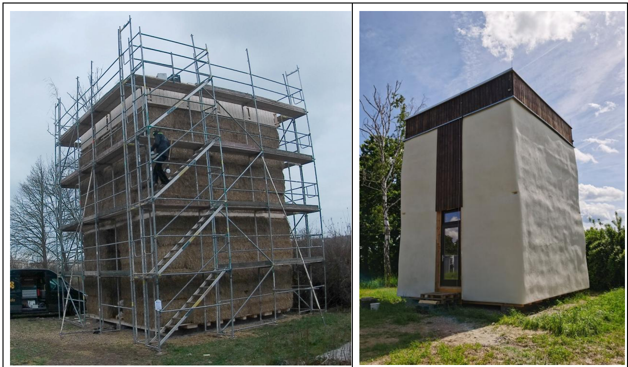
Abbildung 52 Forschungsdemonstrator „zweigeschossiger Strohturm“ im Bau (links) und im fertiggestellten Zustand (rechts), Quelle: Z-Architektur
