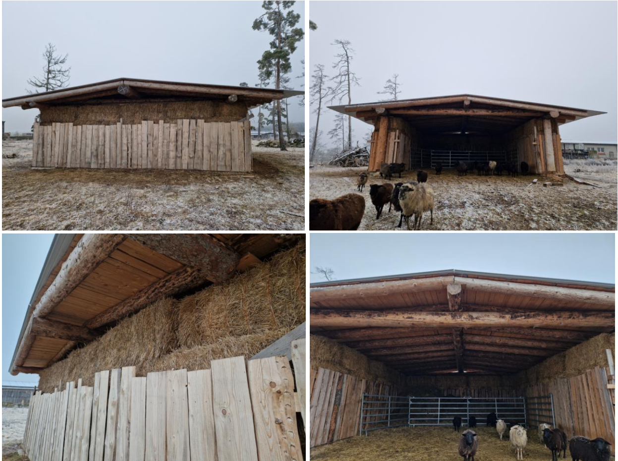
Abbildung 35 Schafstall Hof Herten im dritten Winter der Nutzung, Ansichten aus Richtung der Wetterseite West (oben links) und Ost (oben rechts), Detailansichten der Beplankung Westseite (unten links) und der inneren Verbretterung (unten rechts).
