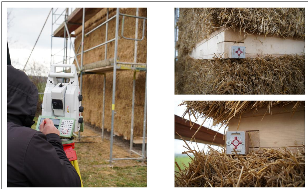
Abbildung 54 Einmessen der Messpunkte mit Tachymeter (links) und Messpunkte am Ringbalken in der mittleren Ebene (rechts)
