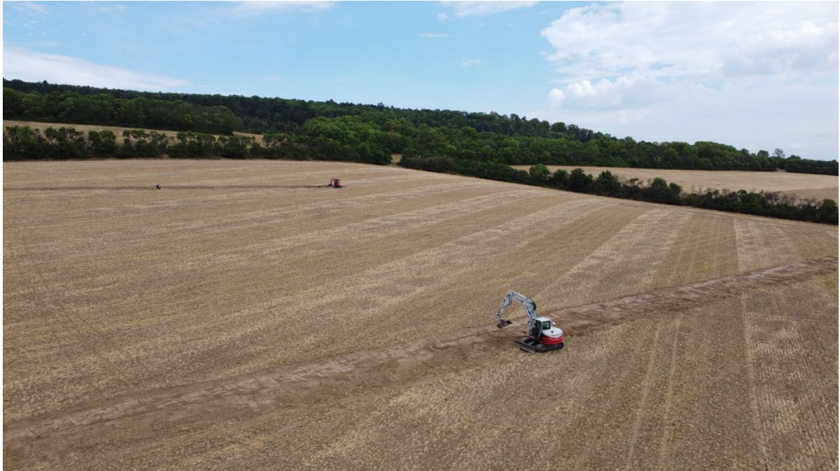
Abbildung 3: Anlage der Retentionsgräben am 05.08.2022.
