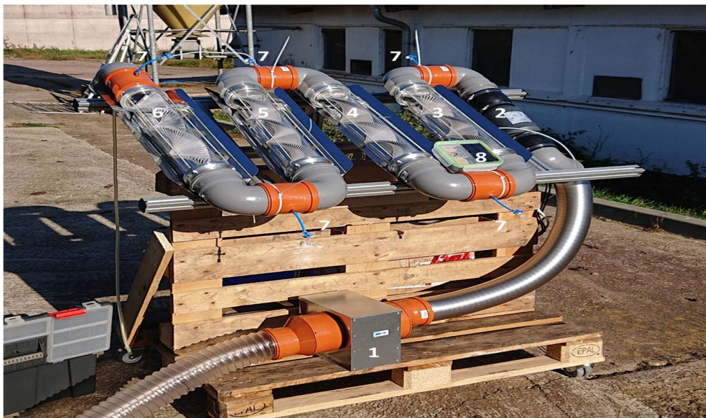
Abbildung 4.1.1: Demonstrator vor der Stallanlage in Reinholterode im solaren Betrieb
