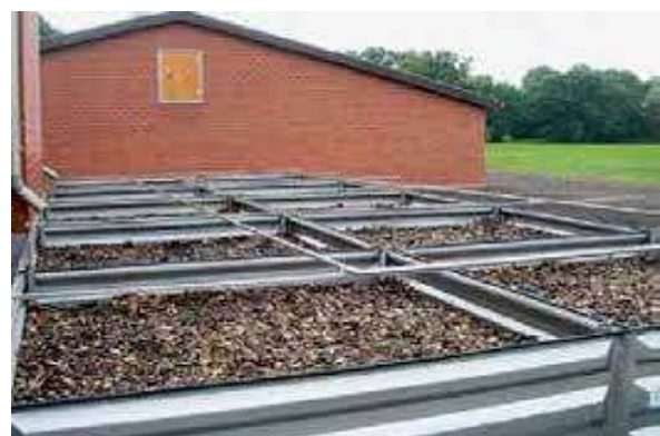
Abbildungen 3.2 und 3.3: Stallablufteinigung mit Biofiltern (Einsatz organischer Filtersubstrate)
