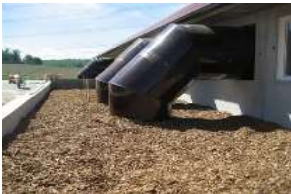
Abbildungen 3.2 und 3.3: Stallablufteinigung mit Biofiltern (Einsatz organischer Filtersubstrate)
