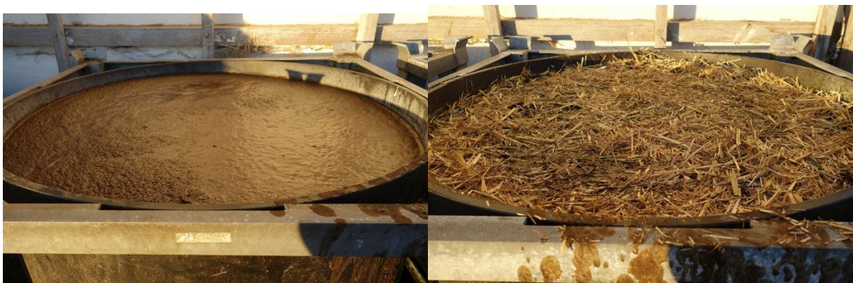
Abbildung 5: Halbtechnische Anlage zur Gärrest- Vererdung bzw. Verstrohung nach Befüllung ohne Zuschläge (links) bzw. mit Zuschlägen (rechts)
