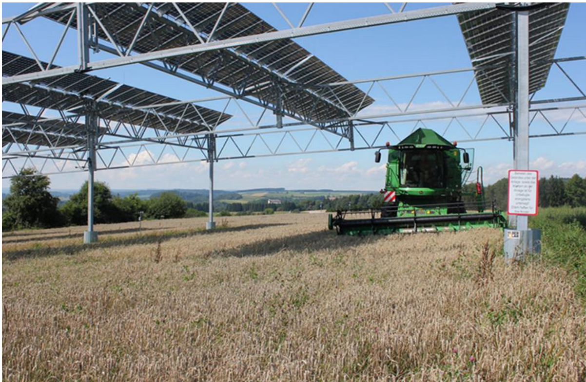
Abbildung 7 Hochaufgeständerte Agri-PV Anlage Hofgemeinschaft Heggelbach. Module in etwa 5 m Höhe. Bild: Hofgemeinschaft Heggelbach
