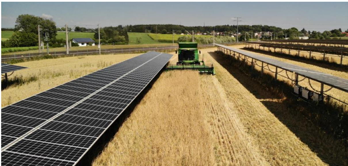
Abbildung 6 Doppelernte und Schletter im bayrischen Althegnenberg ein zwei Hektar großen Acker mit 750 Kilowatt Agri-Photovoltaik-Anlage, Bild: Doppelernte & Schletter
