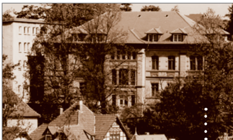
Altes Fachschulgebäude, Gustav-Herrmann-Straße
