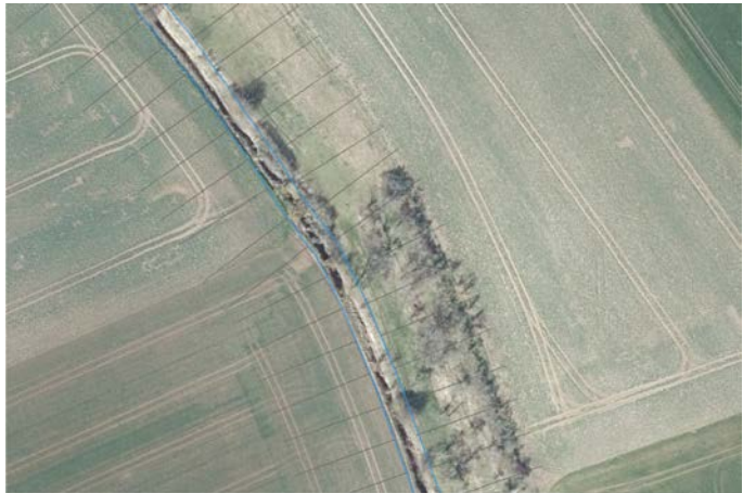
Abbildung 2: Segmentierte Böschungsoberkanten mit versehenen Lotlinien
