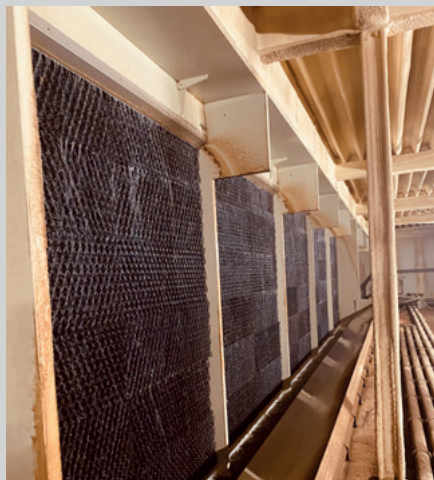
Innenansicht – Abluftreinigung.
