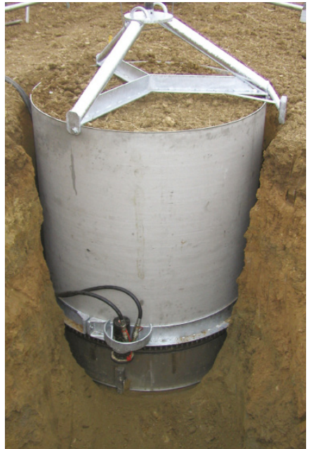
Mit Boden befüllter Behälter beim Einbau
