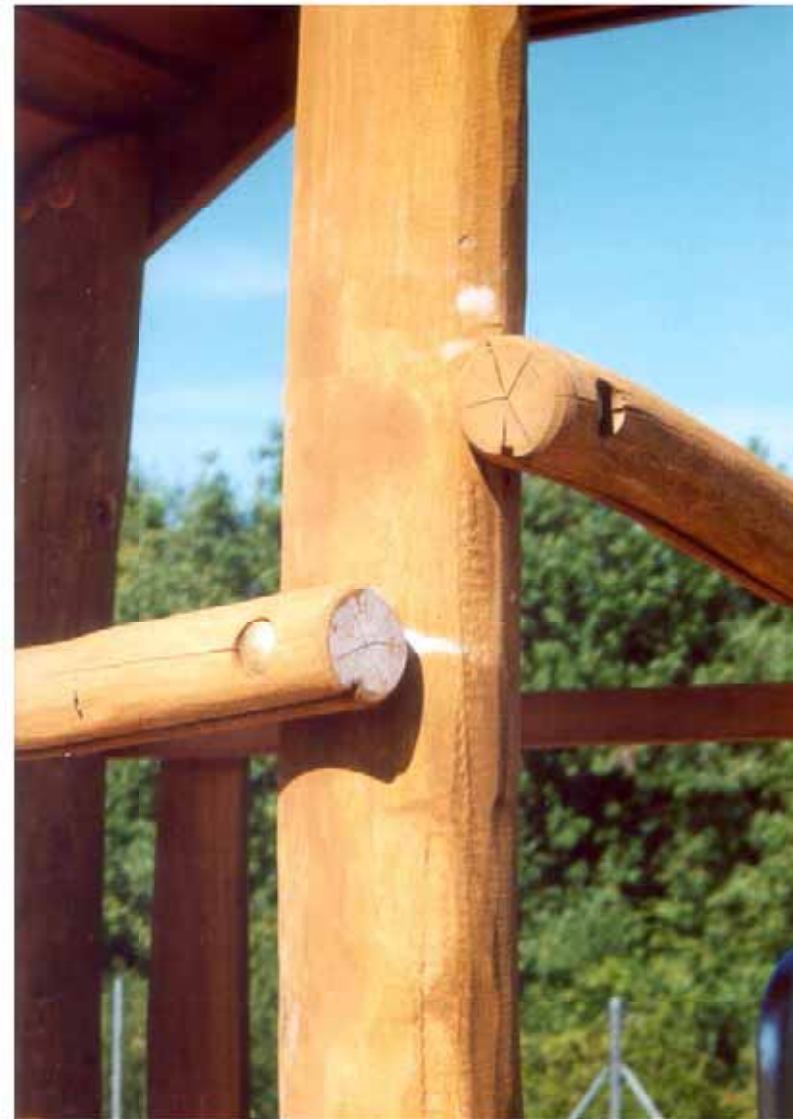
Einbringen von Entlastungsnuten
