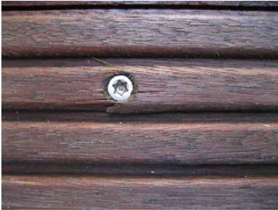
Splitterbildung; ohne Vorbohren verschraubt
