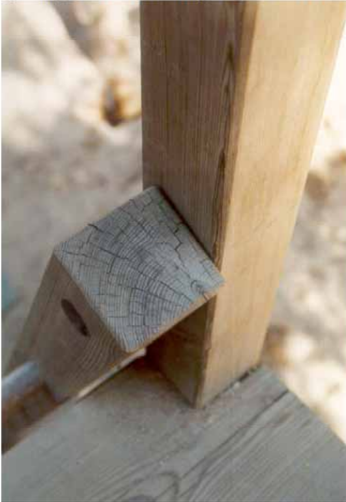
vierstieliger Einschnitt (rundgefräst)
