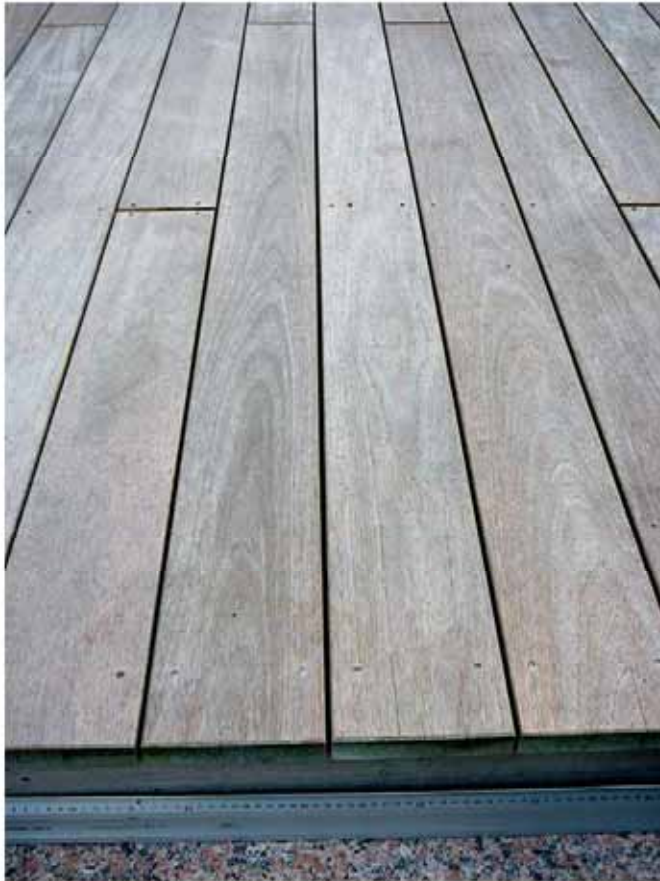
Silbrig graue Oberfläche bereits kurze Zeit nach Bewitterung
