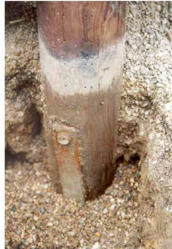
Pfosten in GK 4 nur perforiert und imprägniert
