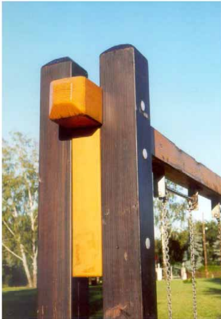
Abschrägung und Beschichtung; zweistieliger Einschnitt
