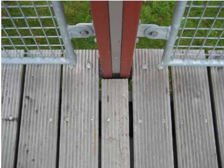
Bohlenbelag aus Lärchenholz mit ausreichender Fugenbreite
