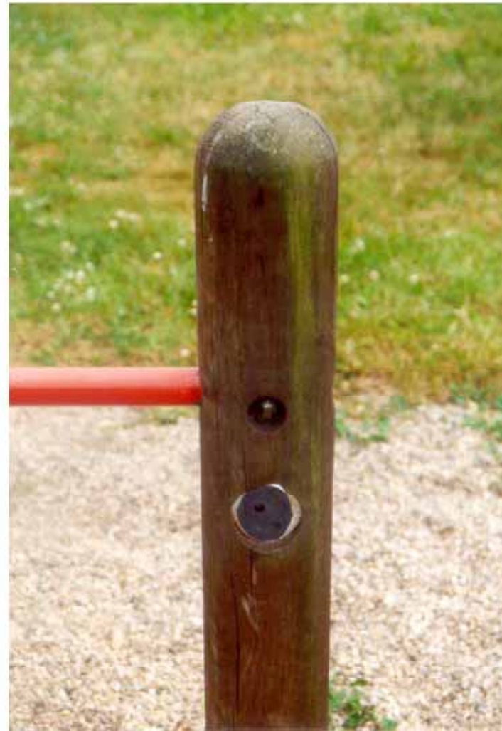
Abrundung des Kopfes und vierstieliger Einschnitt
