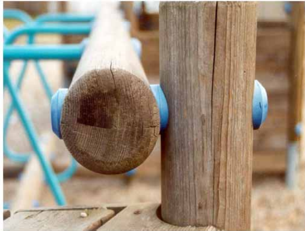
vierstieliger Einschnitt (rundgefräst)
