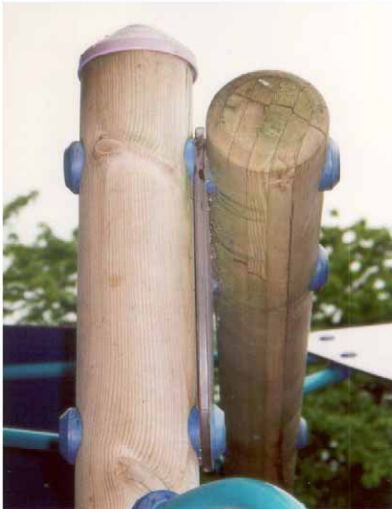
Brettschichtholz rundgefräst
