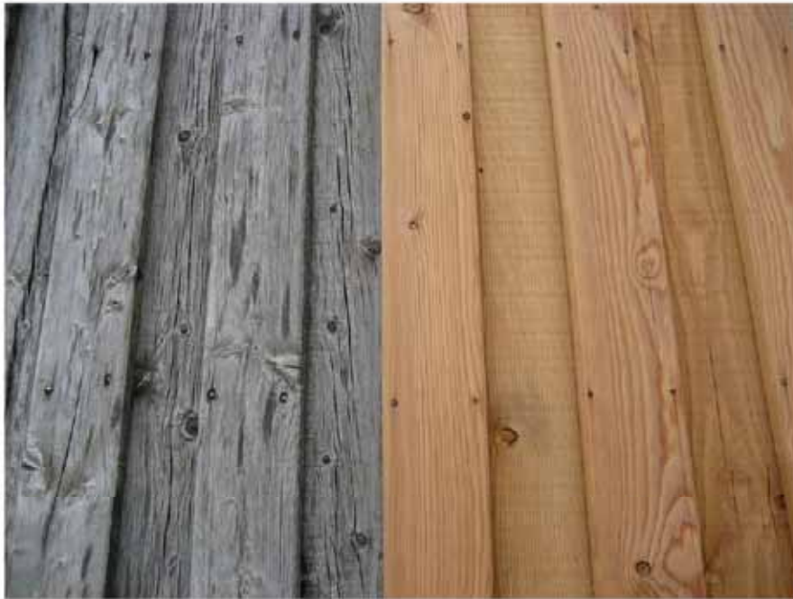
Fassadenbekleidung alt und neu; Alterung durch UV-Strahlung, Bewitterung und Mikroorganismenbefall
