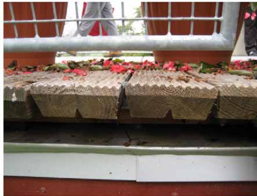
Bohlen zweistielig eingeschnitten, Unterseite mit Entspannungsnut; Träger abgedeckt
