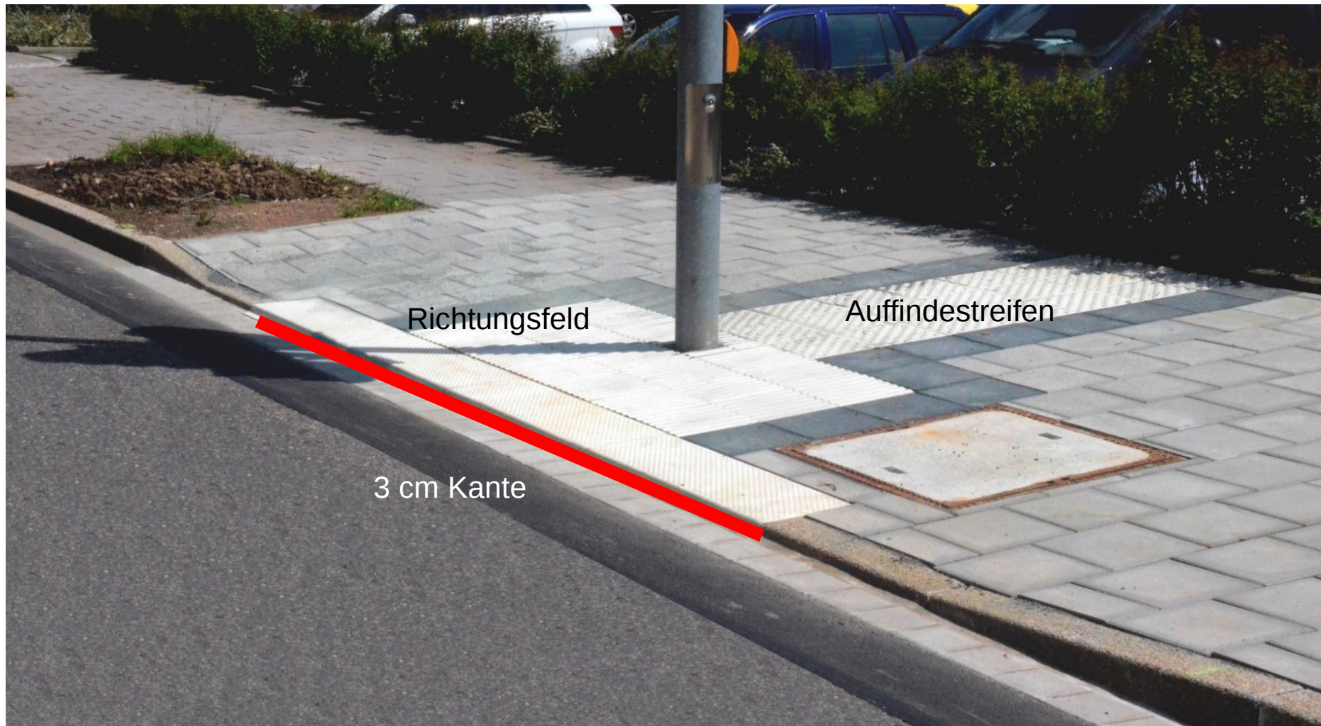
Chemnitz, RAILBETON Querungsbord
