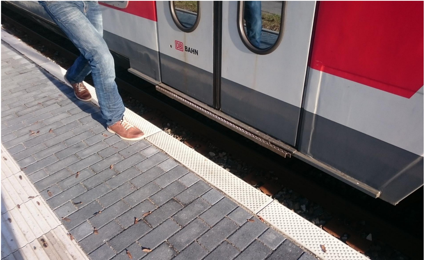
Spaltmaß zu groß
