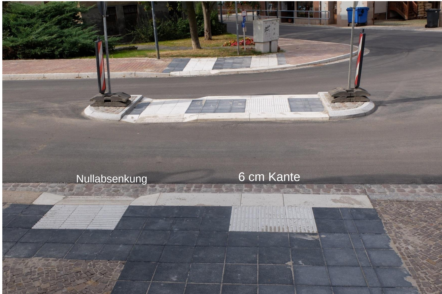
Werdau, RAILBETON CombiFurt
