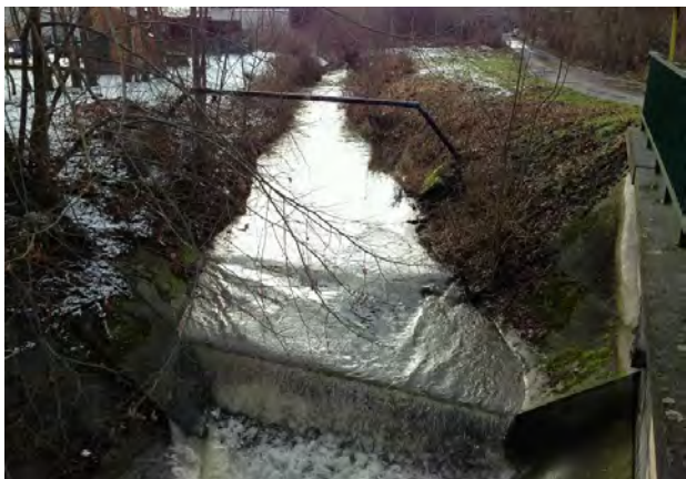
Abbildung 44: Vorhandene Sohlstufe und Sohlschwelle (links); Ersatz der Querbauwerke durch eine Sohlgleite (rechts) (Quelle: TAB)
