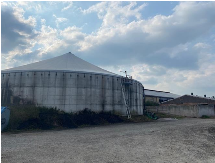
Abbildung 6: Zeltdach mit Mittelstütze
