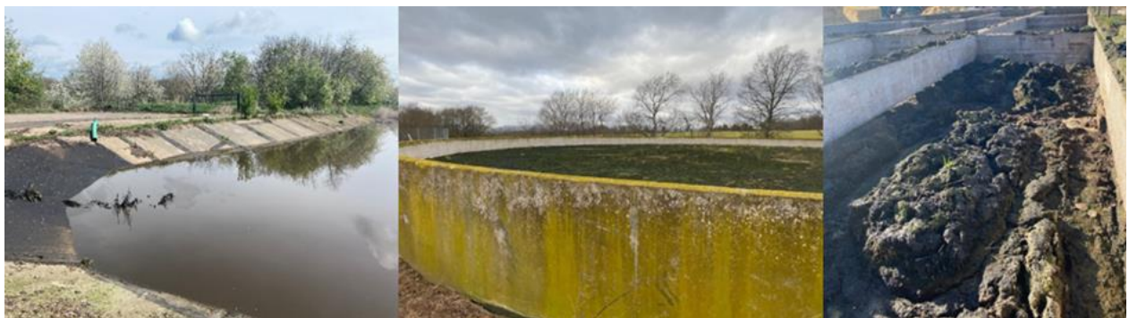
Abbildung 4: Verschiedene Behälterformen und -arten (v. l. n. r. Güllelagune mit Dünngülle, Betonrundbehälter mit flächendeckender Schwimmschicht bei Rindergülle, Betonrechteckbecken mit Rindergülle inklusive ausgeprägter Schwimmschicht)
