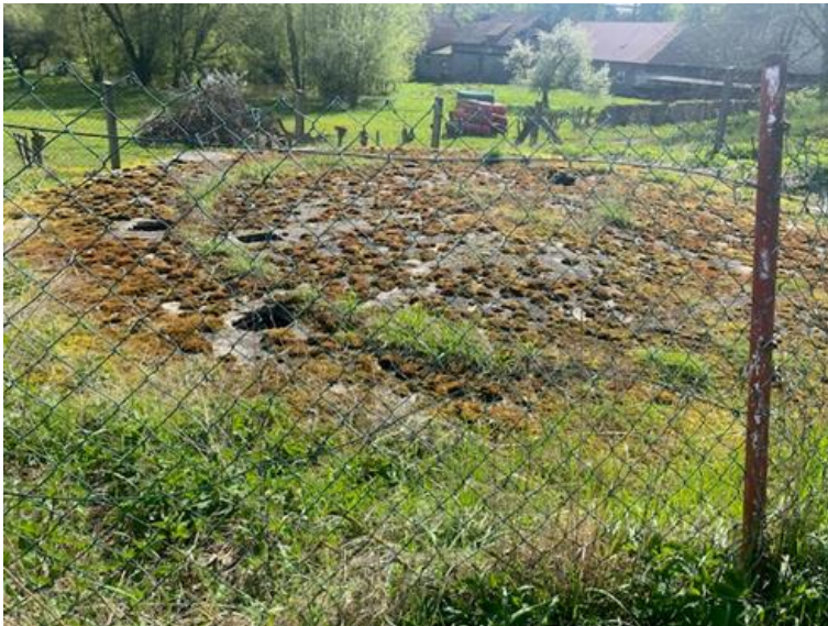
Abbildung 5: Betondecke auf Flüssigmistlager
